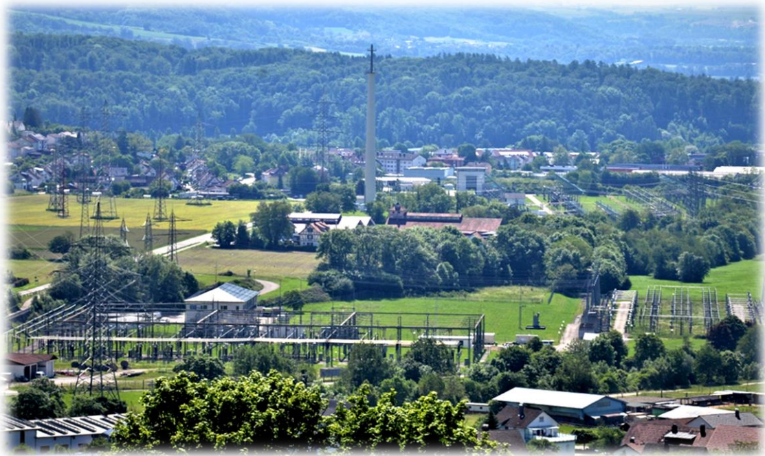
Umspannwerk in Gurtweil
